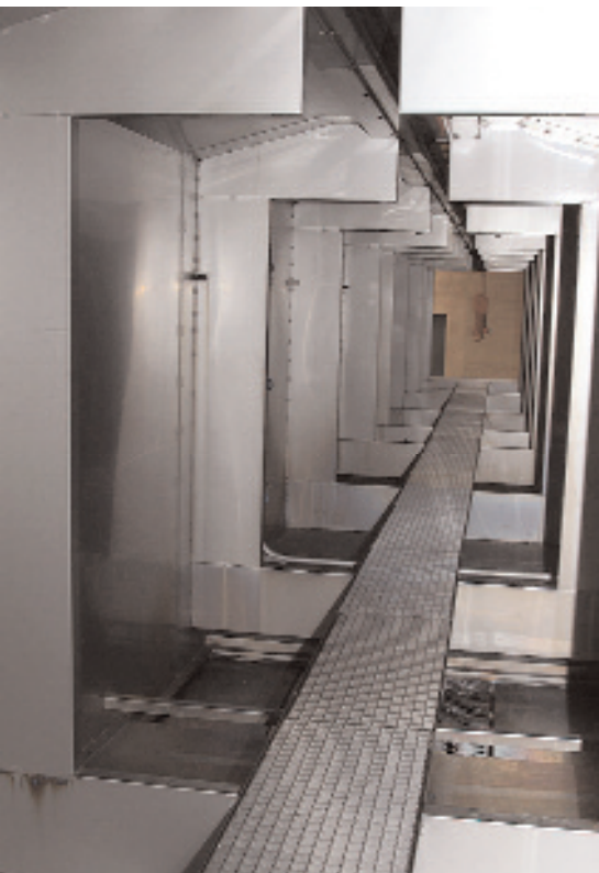
L'intérieur du tunnel TS.
