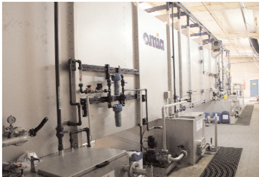
L'extérieur du tunnel TS.
