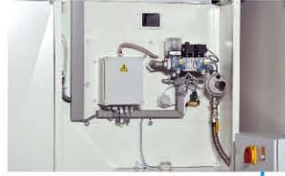
Panoplie gaz de sécurité et de contrôle intégrée et carénée. Conforme norme EN 746-2.
