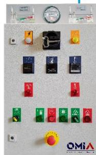
Armoire de puissance avec cadran indicateur de pression cabine.
