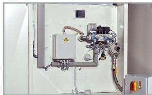
Panoplie gaz de sécurité et de contrôle intégrée. Conforme norme EN 746-2.
